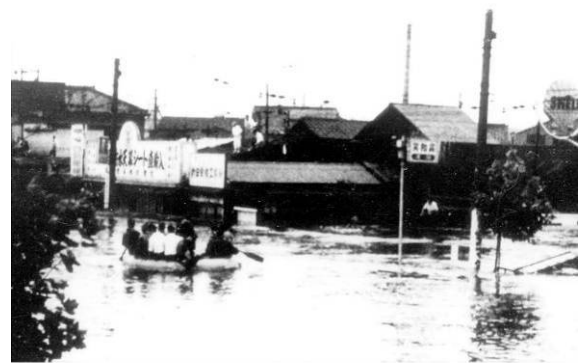
写真 4-3 S24 キティ台風時の浸水状況
