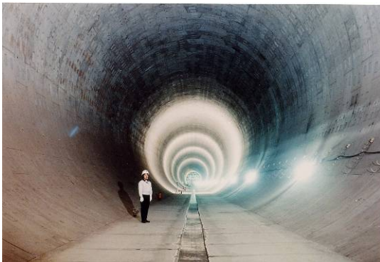
写真 4-2 神田川環状七号線地下調節池 出典：「水害に強い安全な東京をめざして」 東京都建設局
