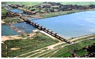
利根大堰 利根川の水は、埼玉県行田市にある利根大堰で取水され、武蔵水路へと導かれます。 (昭和43年(1968年)完成)
