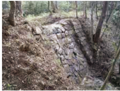
写真-1 御仏えん堤
