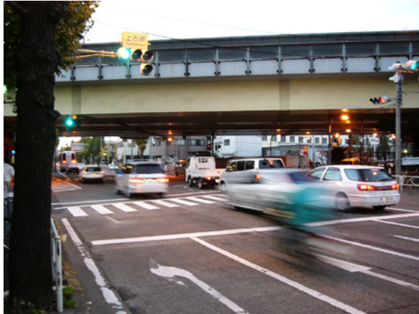
図-2・4(2) 事故発生要因事例 (B2) [陸橋によって、視野が制限されている]
