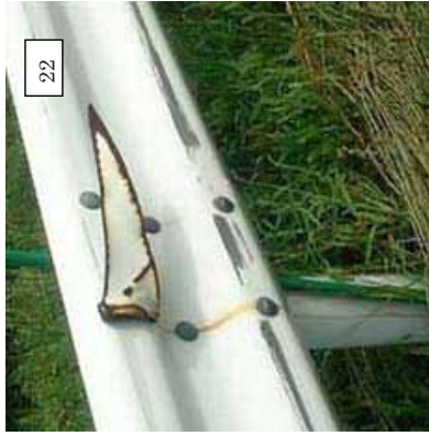
ボルト部（端部ボルト）
