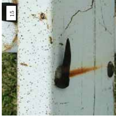
ボルト部（端部ボルト）
