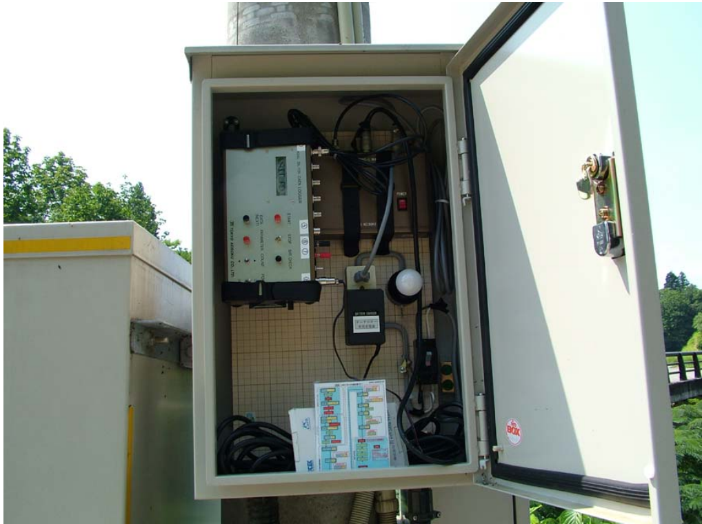
写真－3 データロガーの設置状況（平成17年4月14日撮影）
