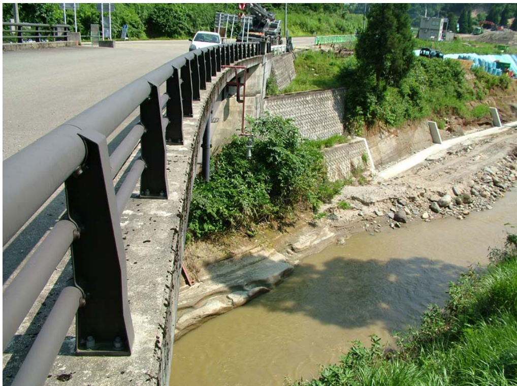
写真－4 水位計の設置状況（平成17年8月2日撮影）
