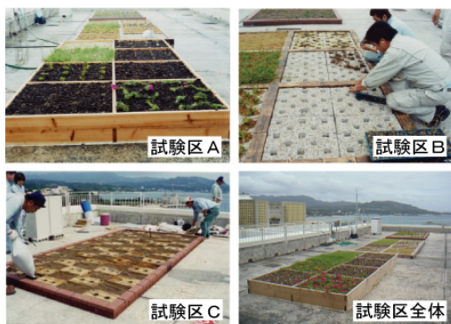
写真－１．屋上緑化試験区の設置状況
