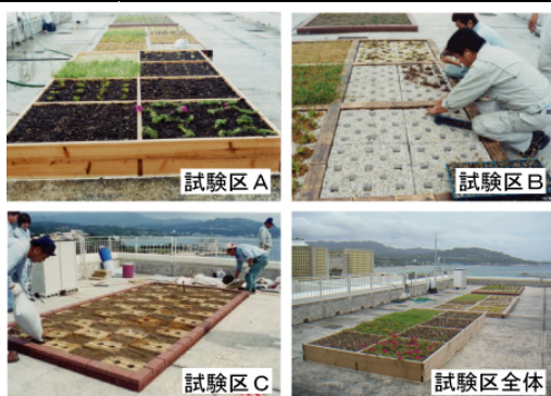
写真－１．屋上緑化試験区の設置状況
