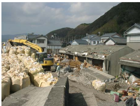
写真-2.8 堤防背後の家屋被害
