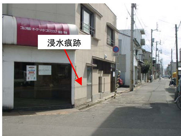
写真-2.3 浸水痕跡（高松市福岡町）
