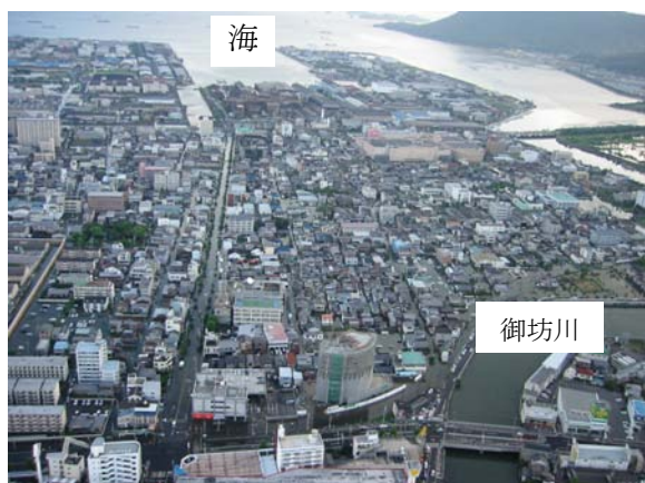
写真-2.1 高松市内の浸水状況（遠景）
