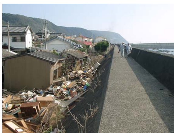
写真-2.10 堤防被災箇所南側の家屋被害
