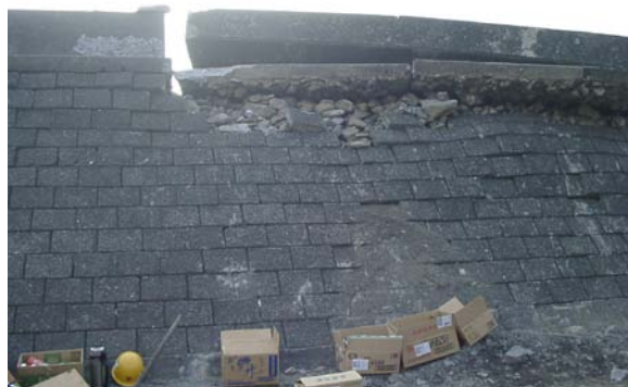
写真-2.9 堤防裏のりの被災状況
