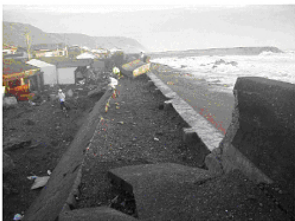
写真-2.7 被災直後の状況(河川局海岸室資料)
