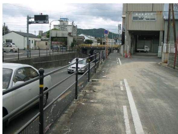
写真-2.4 冠水した地下道（高松市瀬戸内町）
