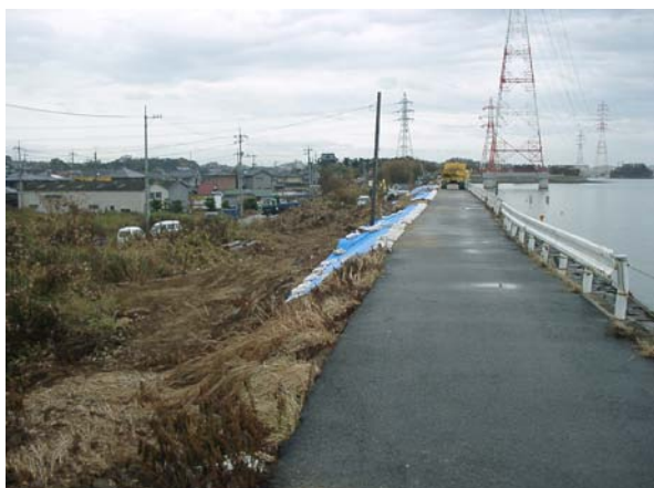
写真-2.5 海岸堤防の裏のりの浸食
