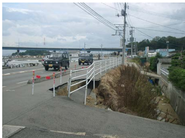
写真-2.6 越流による浸食
