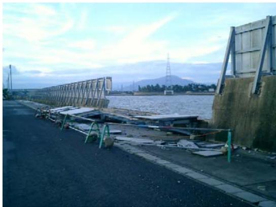
2005年8月31日の護岸上部工の転倒の状況である。パラベットの根元が折れて倒壊している。北から南を見て撮影している。四国電力撮影。
