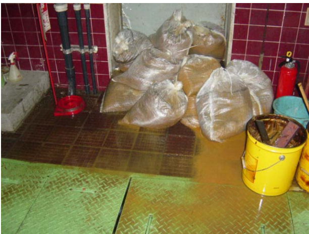
(2004年8月31日0:46高松市下水道施設課撮影) 写真-3 ポンプ施設入口の土嚢設置状況
