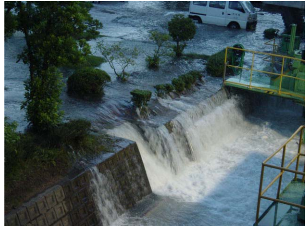
(2004年8月31日5:31高松市下水道施設課撮影) 写真-5 ポンプ施設区画への海水の流入
