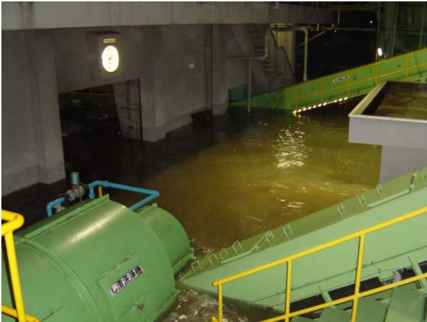
(2004年8月31日0:46高松市下水道施設課撮影) 写真-2 沈砂池上屋の浸水状況
