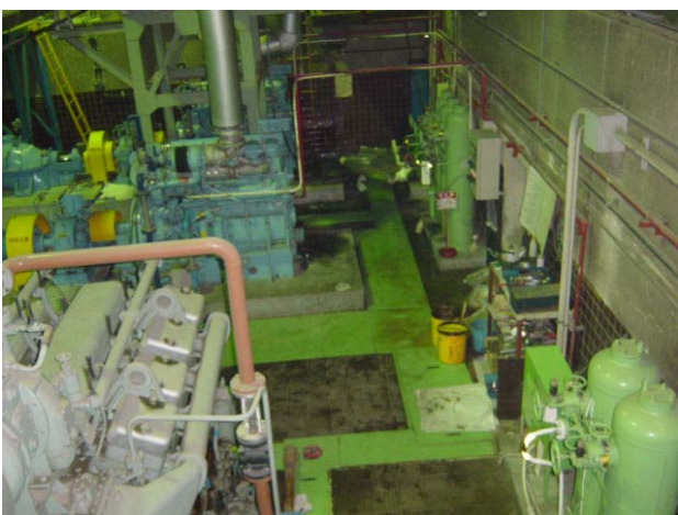
(2004年8月31日0:47高松市下水道施設課撮影) 写真-4 雨水排水ポンプ（奥）と発電機（手前）
