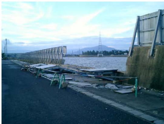
写真-25 丸亀港昭和地区西護岸の上部工の転倒
