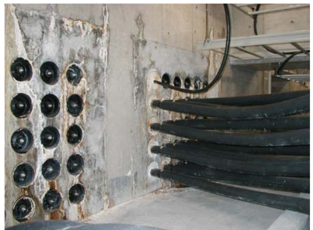
(2005 年 3 月 30 日撮影) 写真-28 三宮変電所 B2F 隔壁の止水工
