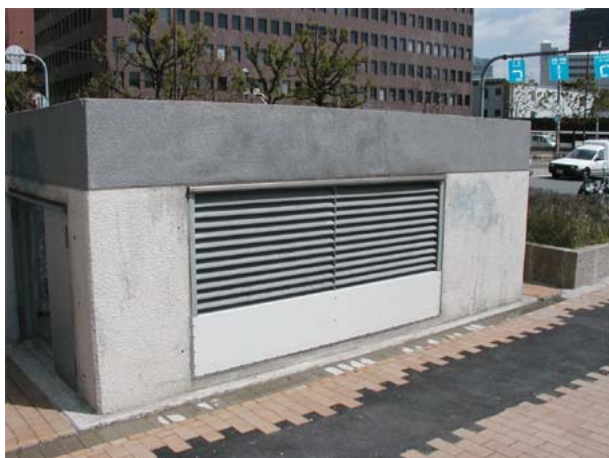
写真-26 関西電力江戸町洞道の換気口
