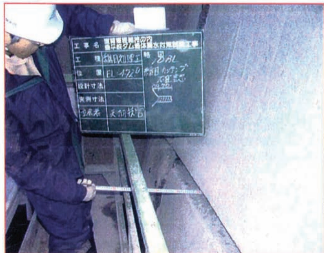
写真 3.5 スリット設置後 (W=40mm L=120mm)
