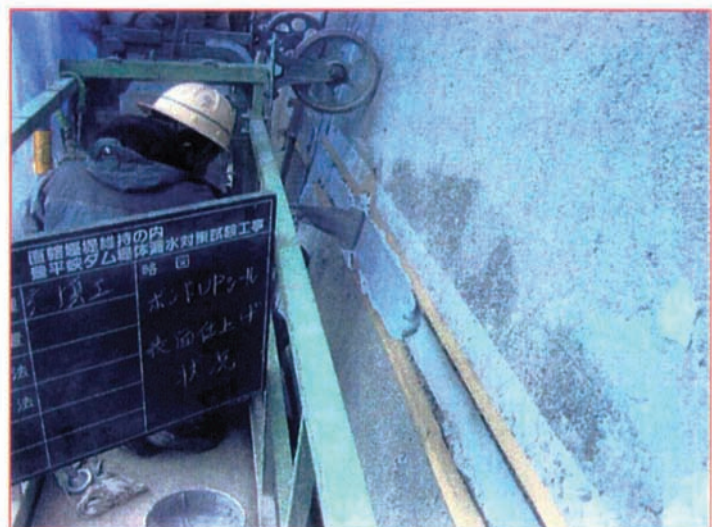
写真 3.6 充填工仕上状況
