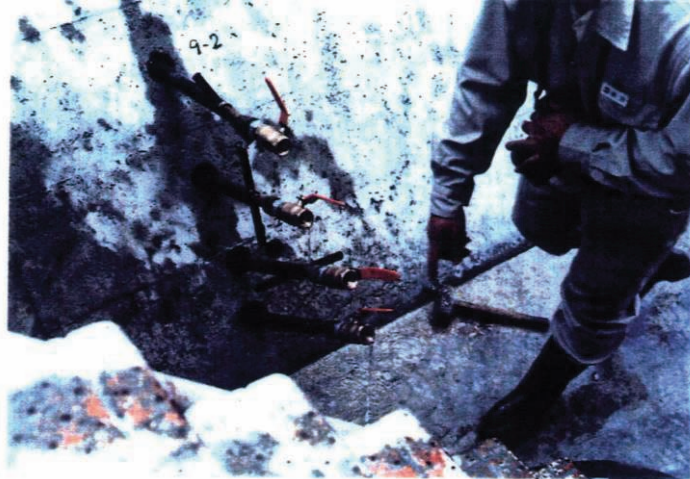
写真 3.6 C工法 水押し通水確認状況
