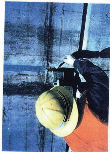
⑤プライマー塗布
