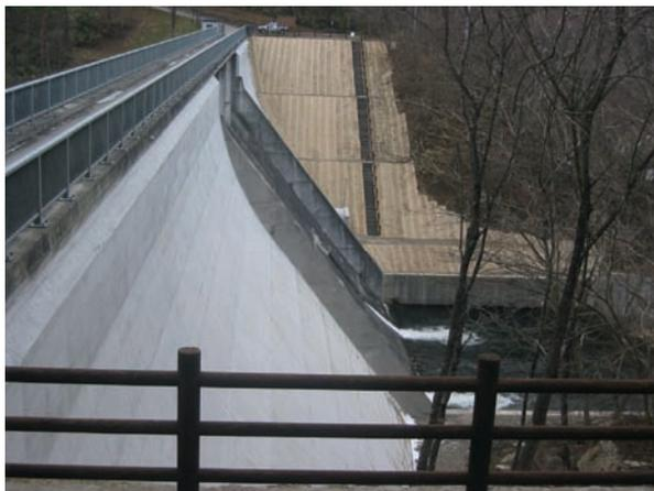
写真 3.43 堤体上流面補修完了（右岸から）
