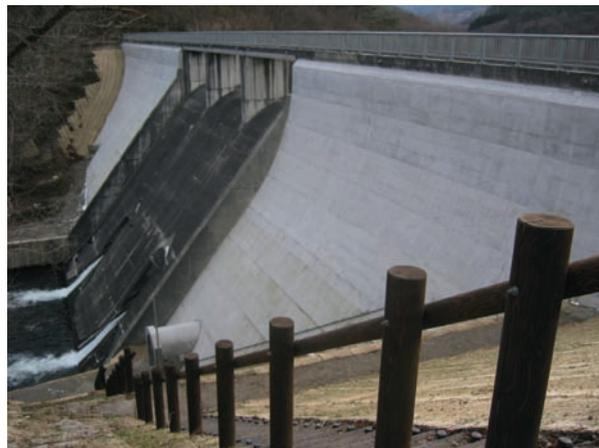
写真 3.42 堤体上流面補修完了（左岸から）
