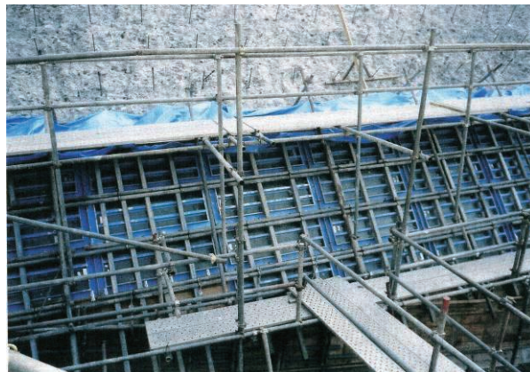
写真 3.35 型枠設置完了
