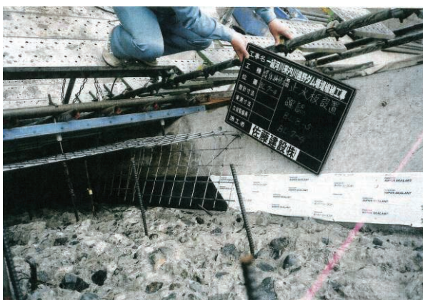
写真 3.36 目地部処理完了
