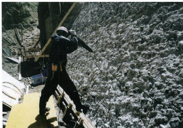
写真 3.31 アンカー打設（削孔）
