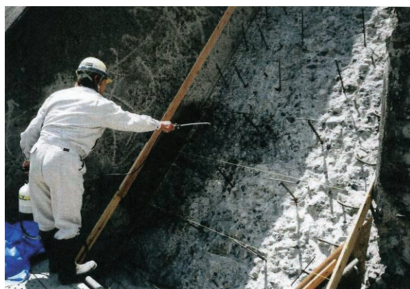
写真 3.37 コンクリート改質剤塗布
