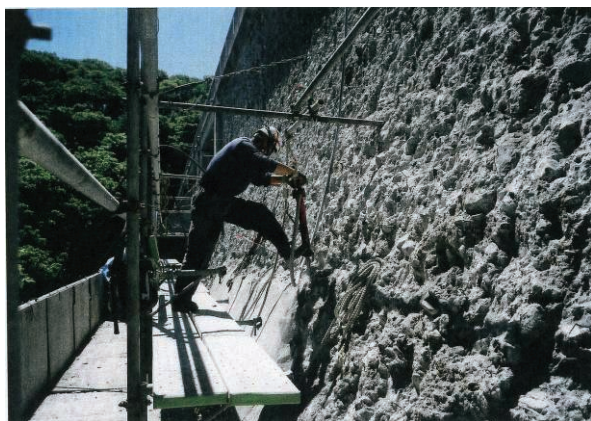
写真 3.28 劣化部除去状況
