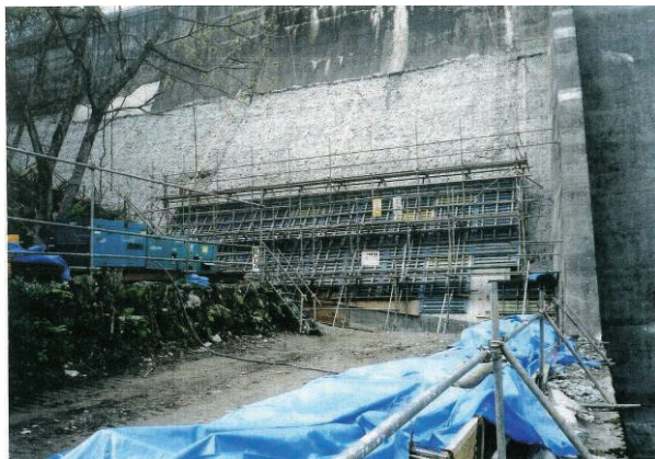
写真 3.35 型枠設置完了
