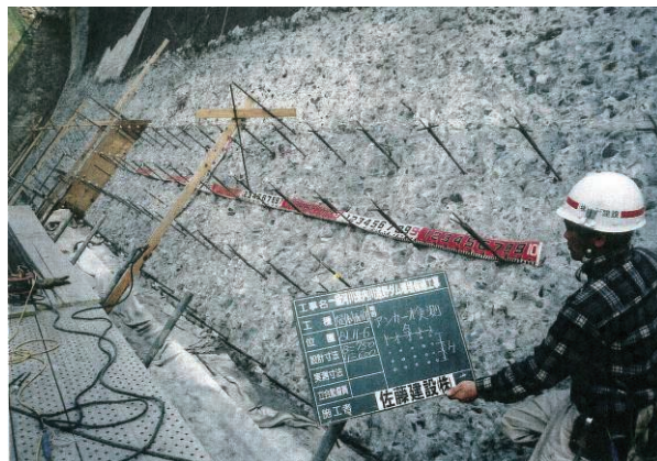
写真 3.32 アンカー打設完了
