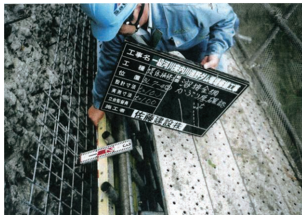
写真 3.34 溶接金網かぶり確認 t=100 mm
