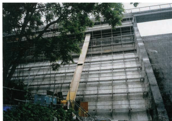
写真 3.27 足場設置状況（右岸側）
