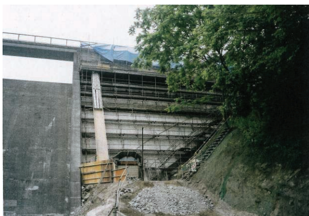
写真 3.26 足場設置状況（左岸側）
