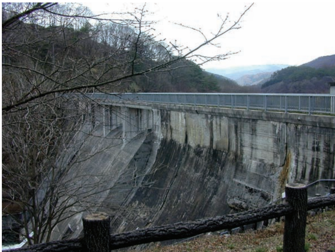
写真 3.25 堤体下流面着手前状況（左岸から）
