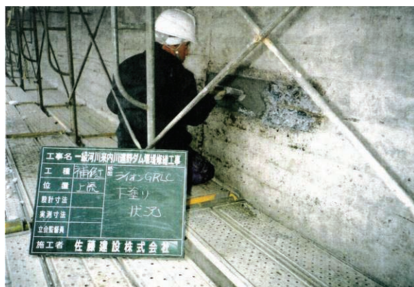
写真 3.17 補修材下塗り(ライオン GRLC)
