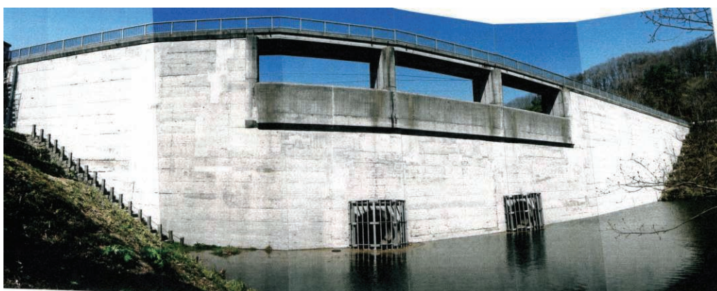
写真 3.23 堤体上流面補修完了
