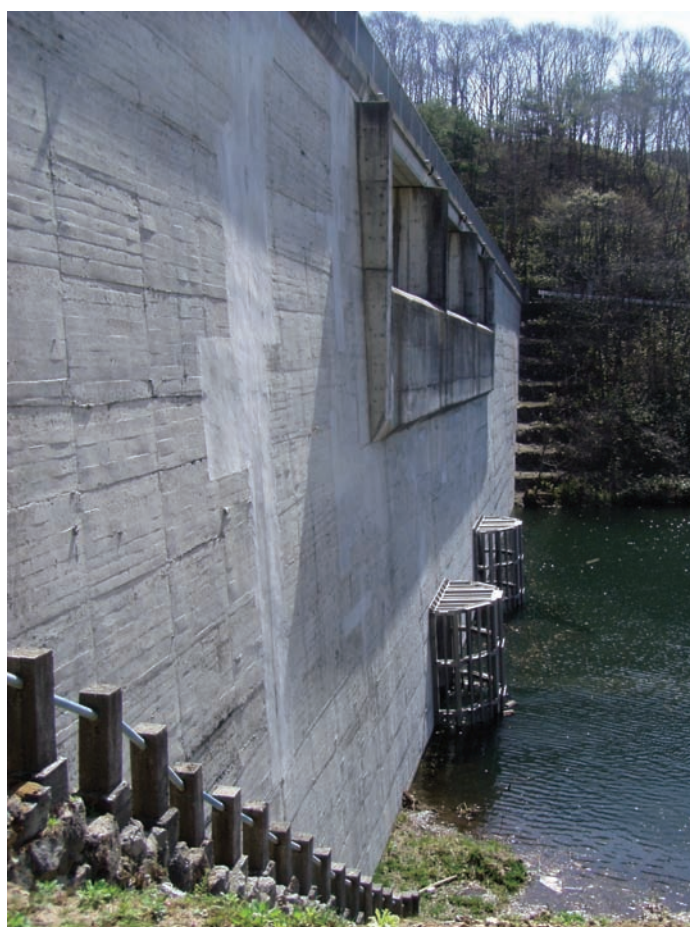
写真 3.24 堤体上流面補修完了（左岸から）
