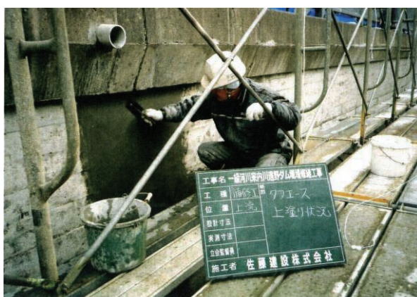
写真 3.21 補修材上塗り(タフェース)
