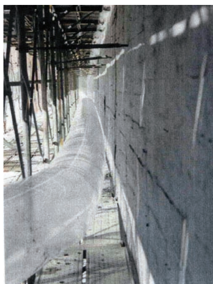
写真 3.22 養生 (ビニルダクト)
