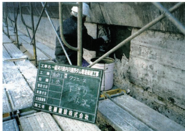
写真 3.20 補修材下塗り(タフェース)
