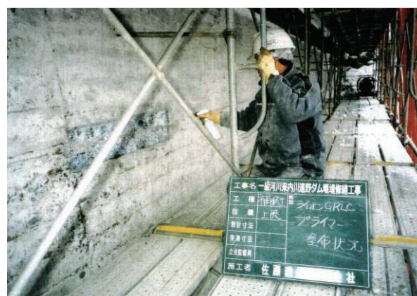
写真 3.16 補修部プライマー処理(ライオン GRLC)
