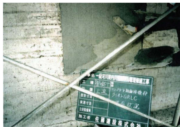
写真 3.18 補修材上塗り(ライオン GRLC)
