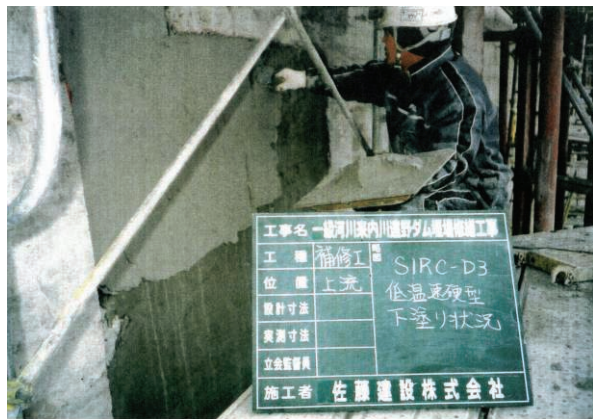
写真 3.13 補修材下塗り (SIRC-D3)
