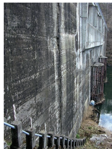
写真 3.2 堤体上流面着手前状況 (左岸から)
