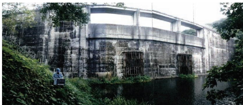
写真 3.1 堤体上流面着手前状況
