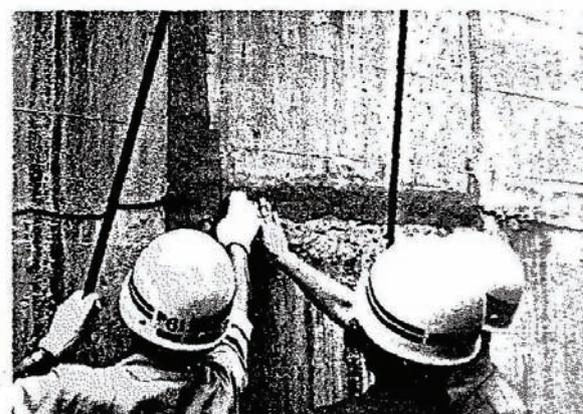
図 3.5 水平クラック処理図
