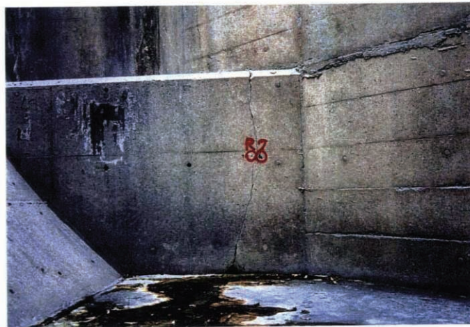
参考写真 左岸第2段 フーチング
