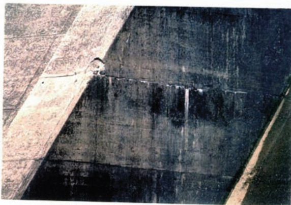
写真 2.2 右岸側導流壁剥離状況
