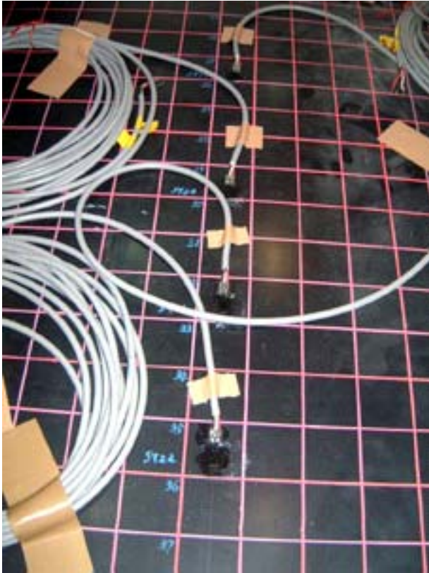
(a) ひずみゲージ貼付状況
