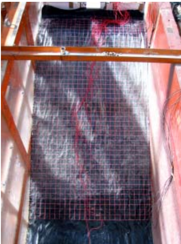
(b) ケースA-2終了後の遮水シート
