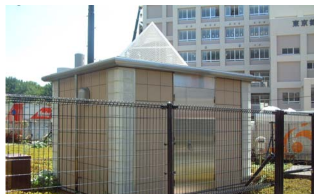
図1 沿道大気常時観測局の設置例 (関東地方整備局新宿測定局)
