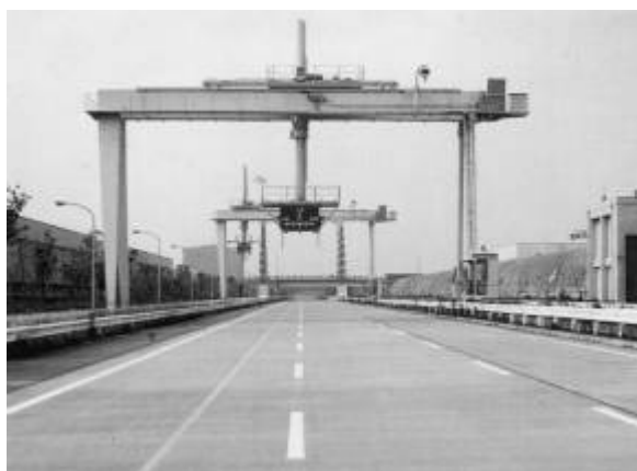
標識屋外実験施設
