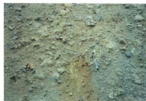
A3-pの風化が進み緩んでいる状況。
