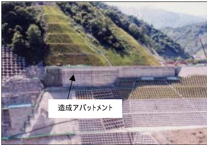
写真 - 5.1.2 長井ダム造成アバットメント工 (設置完了状況)
