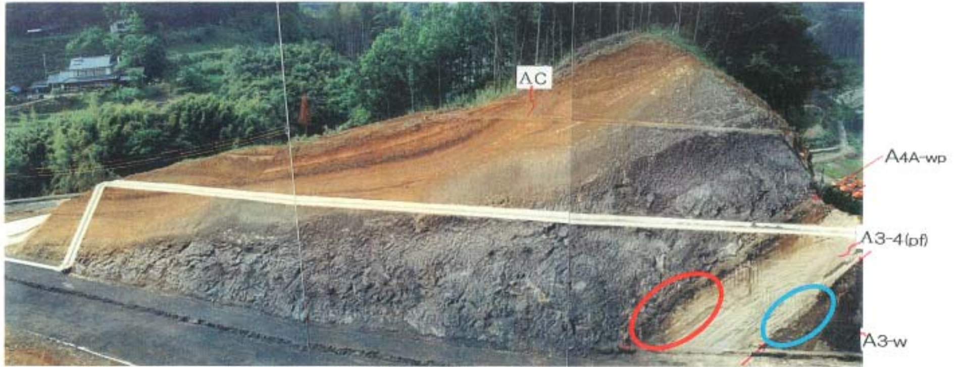
貯水池側の道路掘削法面全景。 Aso-3火砕流から上位の降下火山灰までが分布。写真右よりA3-w, A3-4 (灰白色部), A4A-w, A4A-p, ACと続く。
