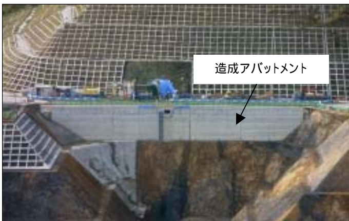
写真 - 5.1.3 我喜屋ダム造成アバットメント工 (前後は道路擁壁工と兼用)
