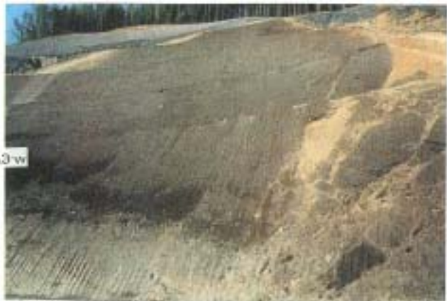
A3-wの全景。下流（右）側は風化が見られ、ブロック状に見える。
