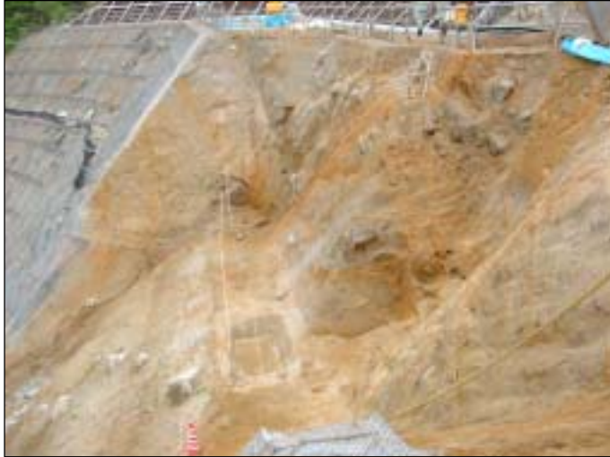
写真 - 5.1.1 琴川ダム造成アバットメント工 (基礎掘削状況)
