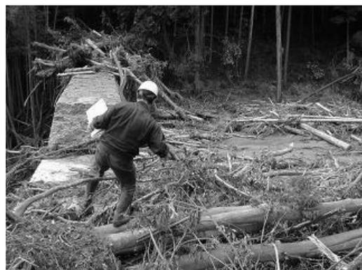
写真-2 砂防堰堤に捕捉された流木
