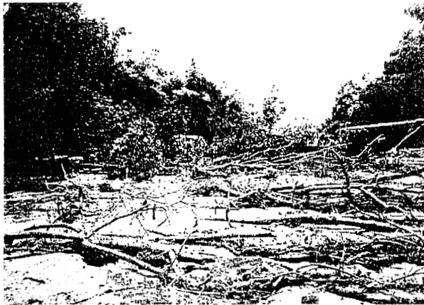
写真-11 砂防えん堤の土砂・流木捕捉状況（2003年7月22日撮影）
