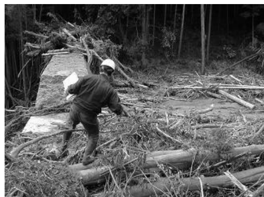
写真-2 砂防堰堤に捕捉された流木
