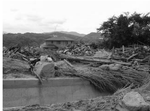
写真-1 下流域の流木による被害状況
