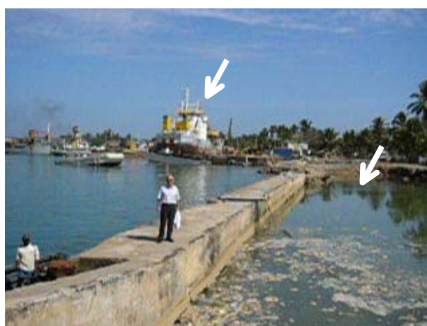
写真-2 護岸背後の流出及び船舶乗上げ（Galle 港）
