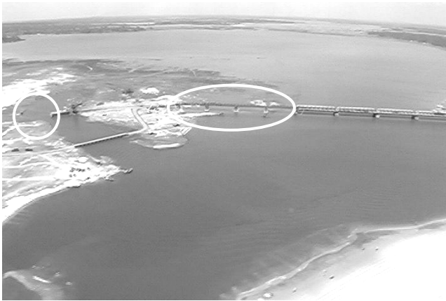
写真-1 Arugam Bay bridge（白線の範囲が流失）3/2 撮影
