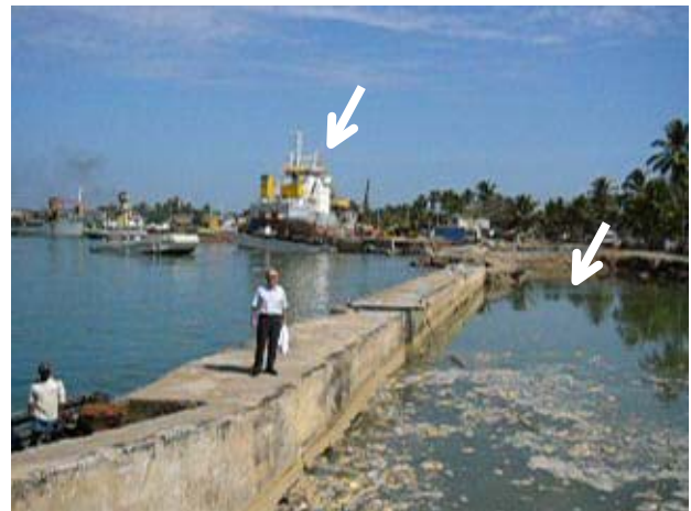
写真-2 護岸背後の流出及び船舶乗上げ（Galle港）
