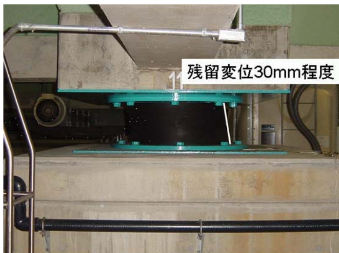
写真 10.3.42 積層ゴムの状況
