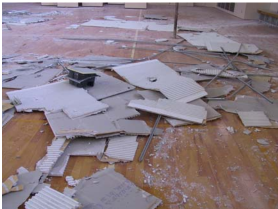
写真 10.3.28 落下した天井とスピーカー
