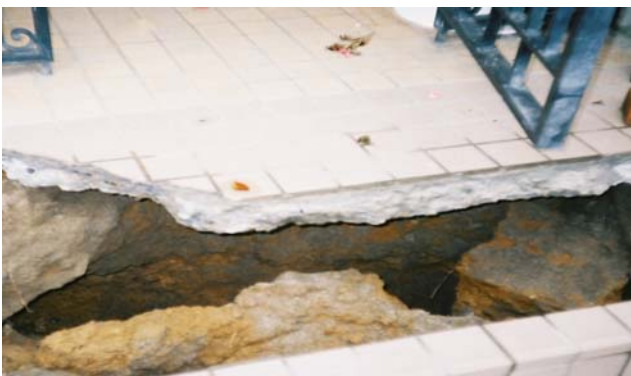
写真 10.3.37 宅地地盤の被害（地すべり、崖くずれ、地割れなどによる被害） 上3段目は、緩斜面での地盤変動によって幅約1.5m程度の横ずれと約1m程度の地盤の沈みこみが生じ、上部構造が崩壊した例
