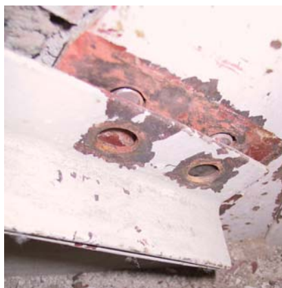
写真 10.3.20 ブレース材端部ボルト破断 (11)
