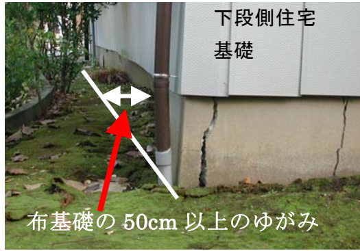
写真 10.3.39 斜面下部の住宅（B邸）の被害状況
