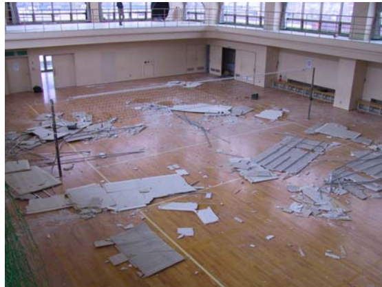
写真 10. 3. 32 落下した天井
