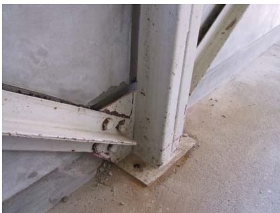
写真 10.3.21 間柱脚部アンカーボルト破断(16)
