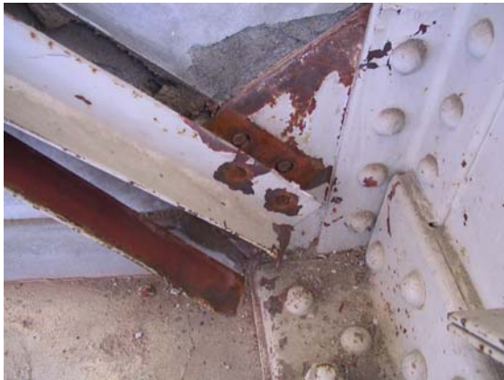
写真 10. 3. 24 ブレース材端部ボルト破断 写真 10. 3. 25 間柱脚部ボルト破断、ずれの跡 (22) (24)
