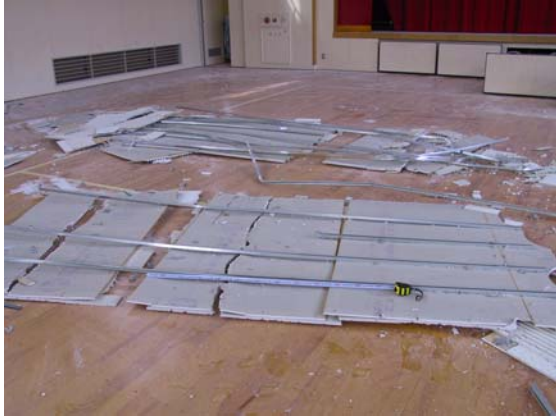
写真 10. 3. 30 落下した天井
