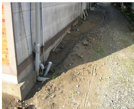
写真 10. 3. 40 液状化による被害（刈羽村）
