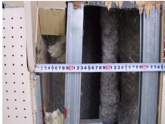
写真 10.3.36 ブレース材端部 (柱は H-500?) (54)
