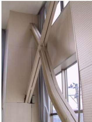
写真 10.3.35 ブレース材の座屈(47)
