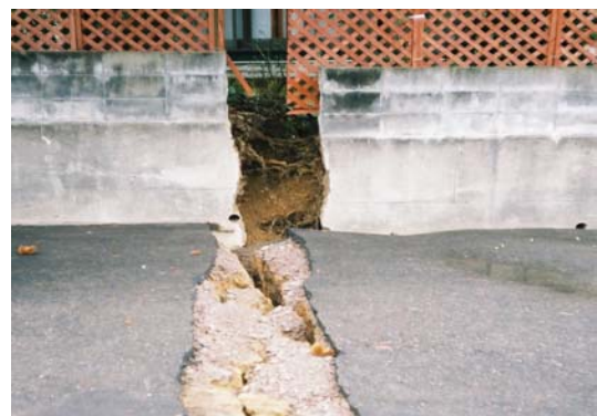
写真 10.3.37 宅地地盤の被害（地すべり、崖くずれ、地割れなどによる被害） 上3段目は、緩斜面での地盤変動によって幅約1.5m程度の横ずれと約1m程度の地盤の沈みこみが生じ、上部構造が崩壊した例
