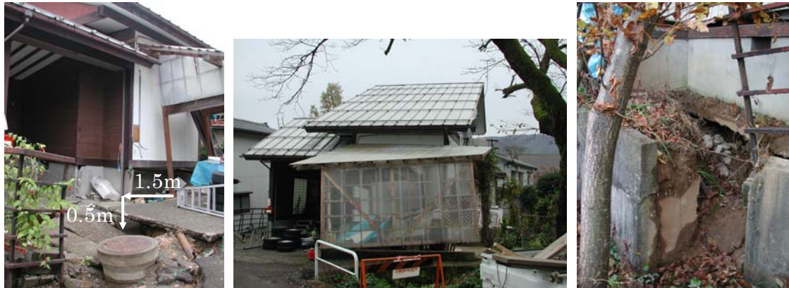
写真 10.3.38 斜面上部の住宅 (A 邸) の被害状況
