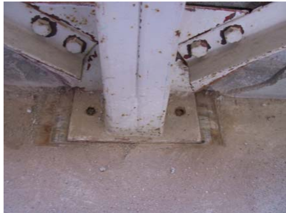
写真 10. 3. 24 ブレース材端部ボルト破断 写真 10. 3. 25 間柱脚部ボルト破断、ずれの跡 (22) (24)
