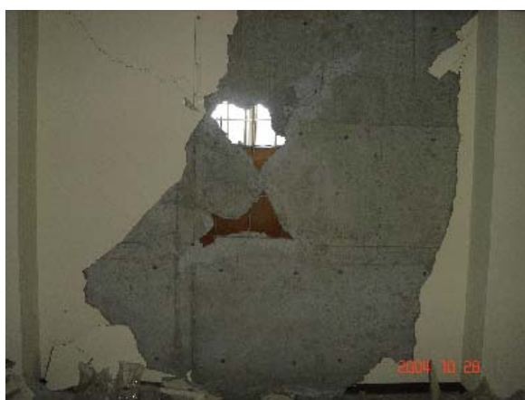
写真 10.3.16 昭和 44 年竣工棟の壁部材のせん断破壊
