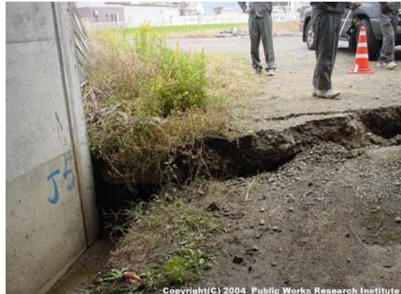
写真 9. 2. 24 ボックスカルバートの沈下
