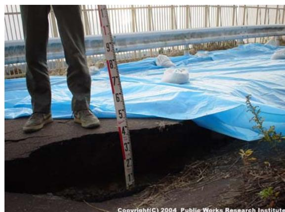
写真 9.2.19 天端部での沈下
