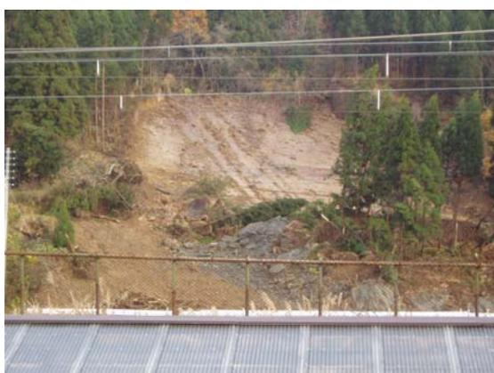
写真 9.2.42 北側の崩壊箇所のすべり面
