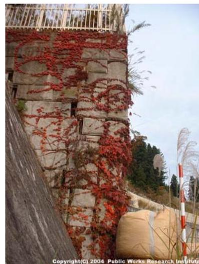
写真 9.2.17 補強土擁壁の被災状況
