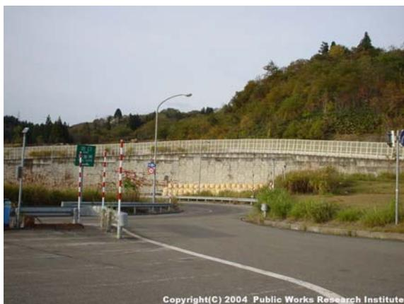
写真 9.2.18 補強土擁壁の全景
