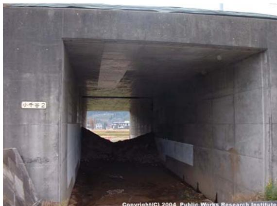
写真 9.2.20 継目部の開きにより盛土材が
