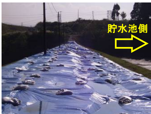
写真 8.3 天端亀裂のブルーシートによる保護 (浅河原調整池)
