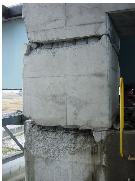
(e) P8 左岸・下流側
