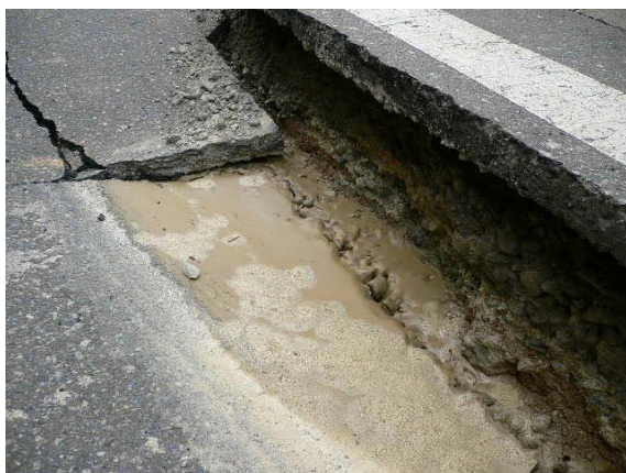
写真 6.5 アスファルトの割れ目からの噴砂 (小千谷市)
