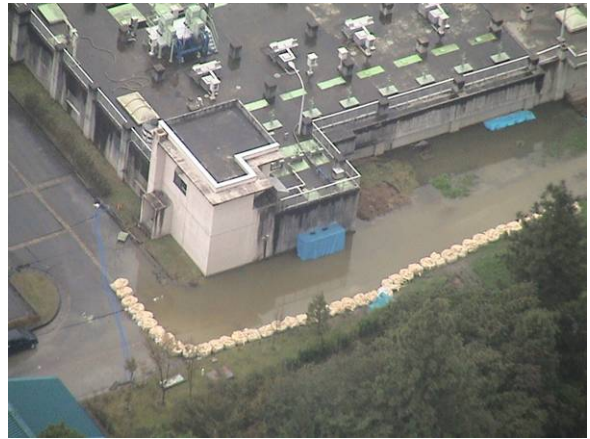
写真 6.2 流入下水の漏水
