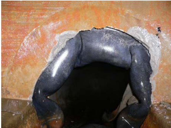
写真 6.7 マンホールと管渠の接合部のズレ (長岡市)
