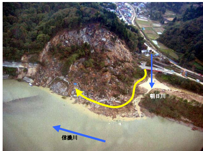
写真 5.43 車両埋没地点までの経路
