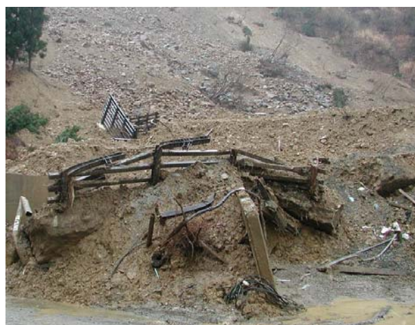
写真 5.40 雪崩予防柵の被災事例(2) (斜面崩壊による土石の堆積)
