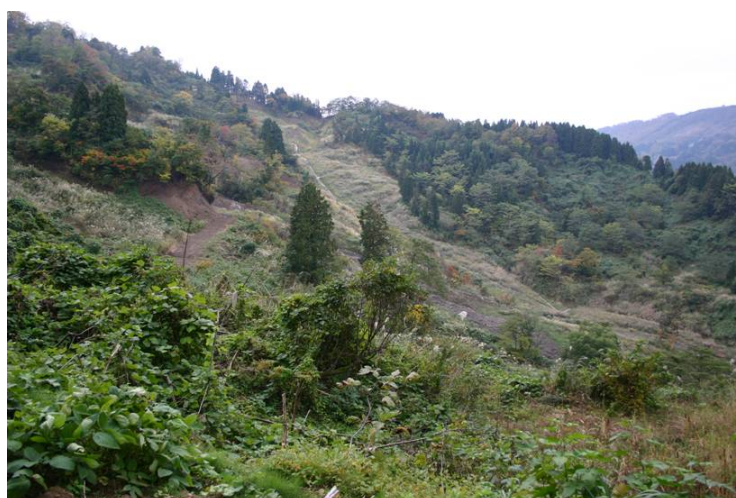
写真 5.29 捨石地すべり全景
