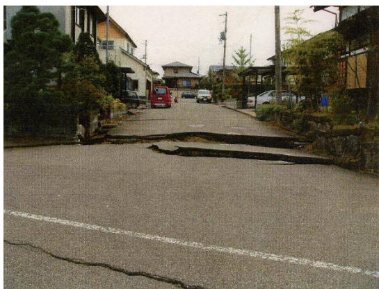
写真5.32 高町団地1丁目西側の亀裂発生状況
