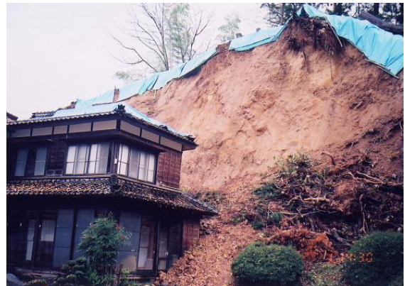
写真 5.37 滝谷北地区南斜面の崩壊
