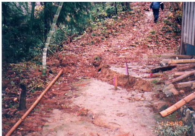
写真 5.38 滝谷北地区西斜面亀裂発生状況
