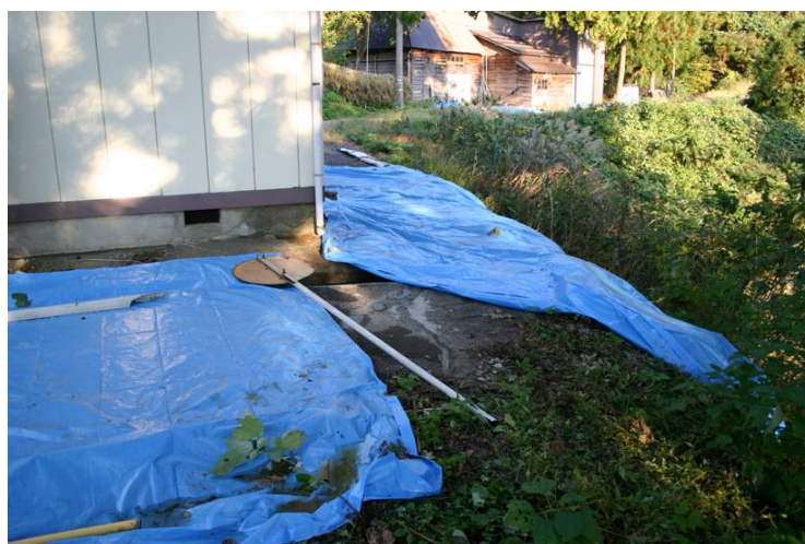
写真 5.31 中船地区の頭部変状状況
