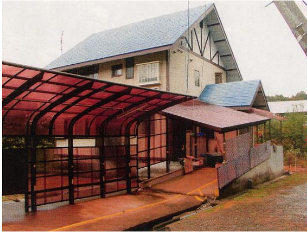
写真 5.35 鶴ヶ丘団地家屋被災状況
