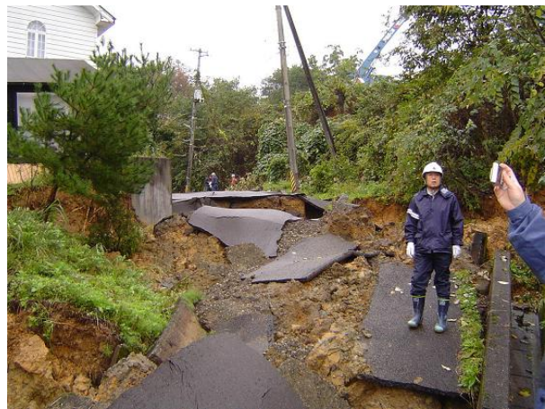
写真 5.34 鶴ヶ丘団地北部最下段宅地斜面における崩壊状況
