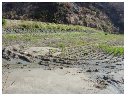
写真 5.16 崩積土堆積部。
