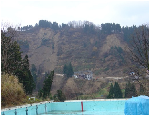
写真 5.19 羽黒トンネル坑口付近の地すべり性崩壊
