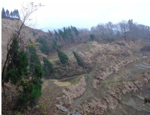
写真 5.23 地すべり上部。
