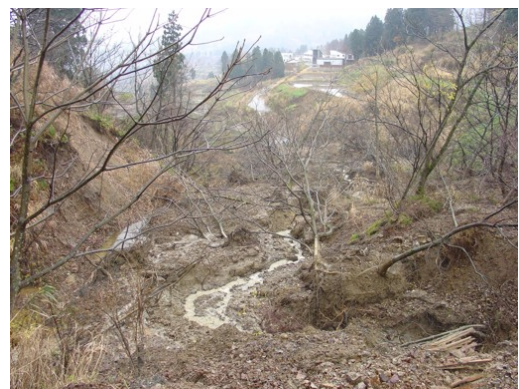
写真 5.22 三峰山から流下した崩土の状態
