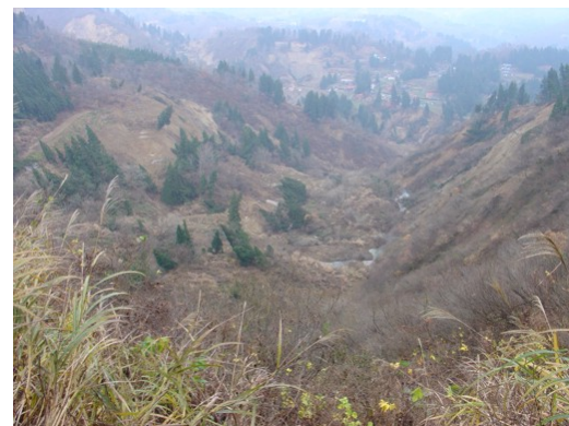
写真 5.25 地すべり末端部。
