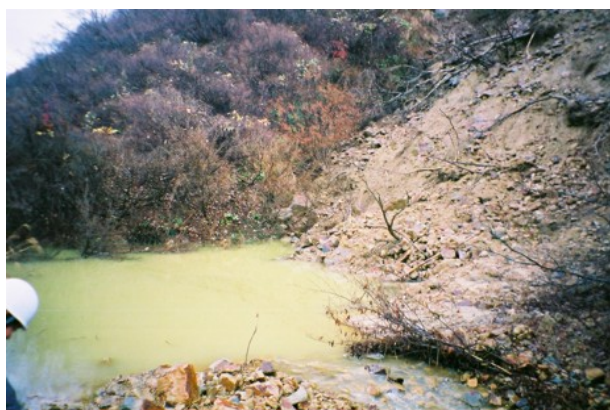
写真 5. 27 神沢川上流域の河道閉塞の越流状況
