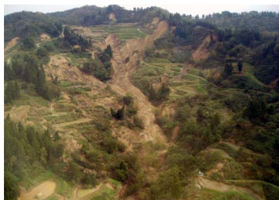
写真-5.1 大規模な地すべり（山古志村山中）
