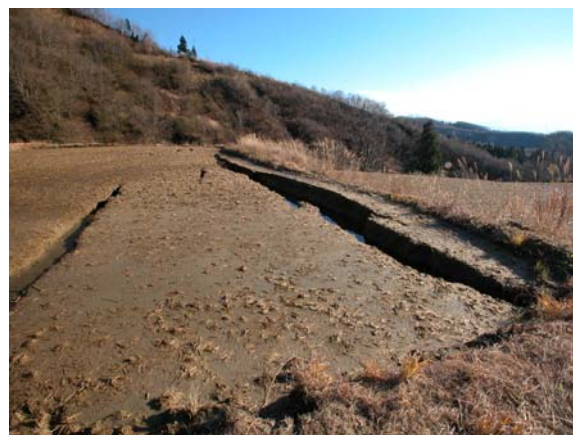
写真 5.7 寺野地区地すべり滑動範囲より上部の変状（平成16年12月14日撮影）
