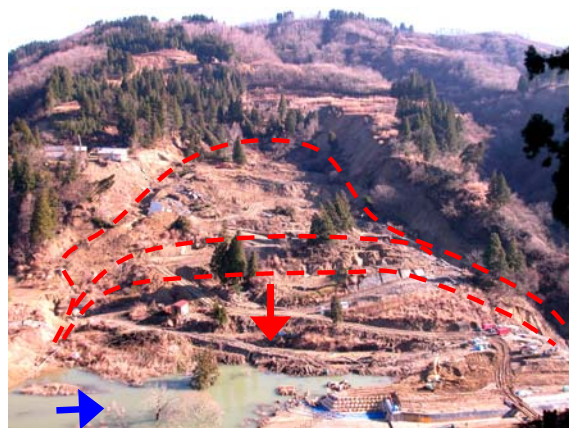
写真 5.6 寺野地区地すべりの全景（平成16年12月14日撮影）
