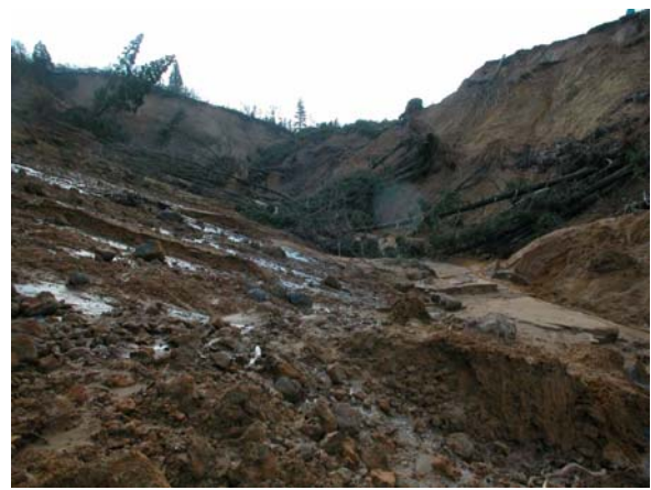
写真5.4 すべり面下の基盤の露頭部
