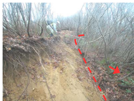
写真 5.5 東竹沢地区地すべりの上部斜面に見られる変状
