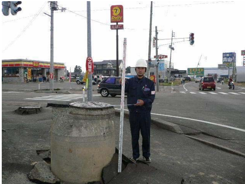
写真 G 6.1 小千谷市桜町地区のマンホールの浮上がり 写真正面のマンホールでは約 1.1m の浮上がりが生じた。
