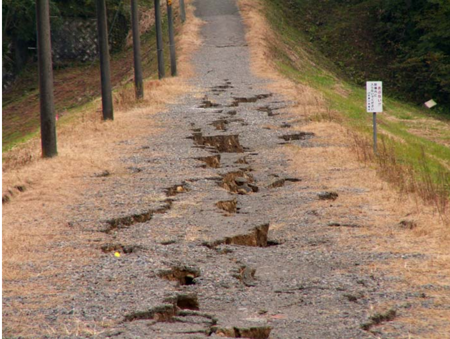
写真 G 8.1 JR東日本 浅河原調整池の天端状況
