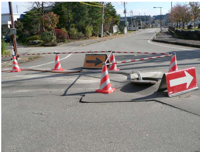
写真 G 6.2 小千谷市若葉地区の管渠の応急復旧状況
