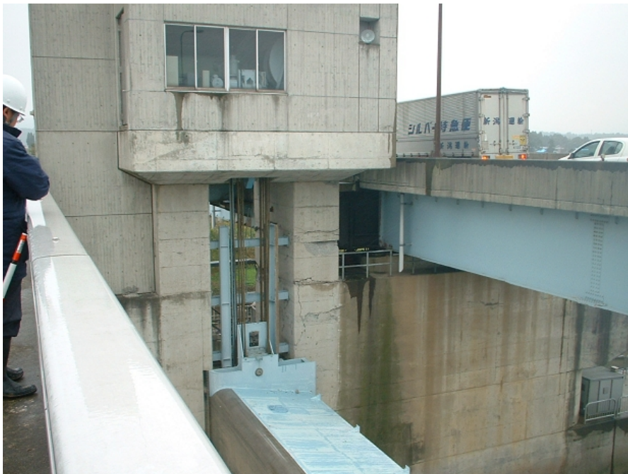
写真 G 7.2 妙見堰の門柱の損傷 (写真右は越の大橋)
