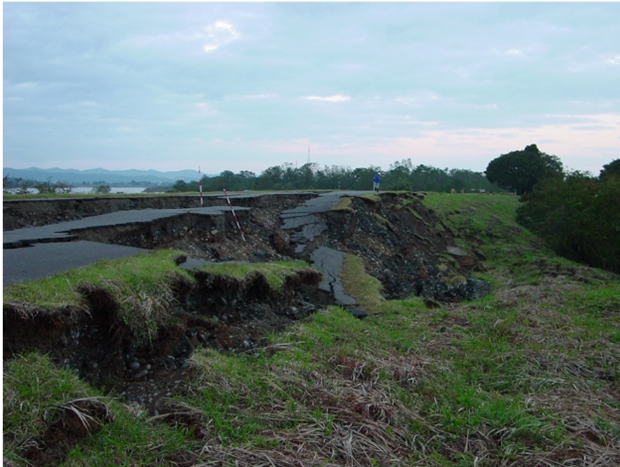
写真 G 7.1 信濃川右岸 29.0km 付近(長岡市三 俣野)の堤防崩壊状況 (北陸地方整備局撮影)
