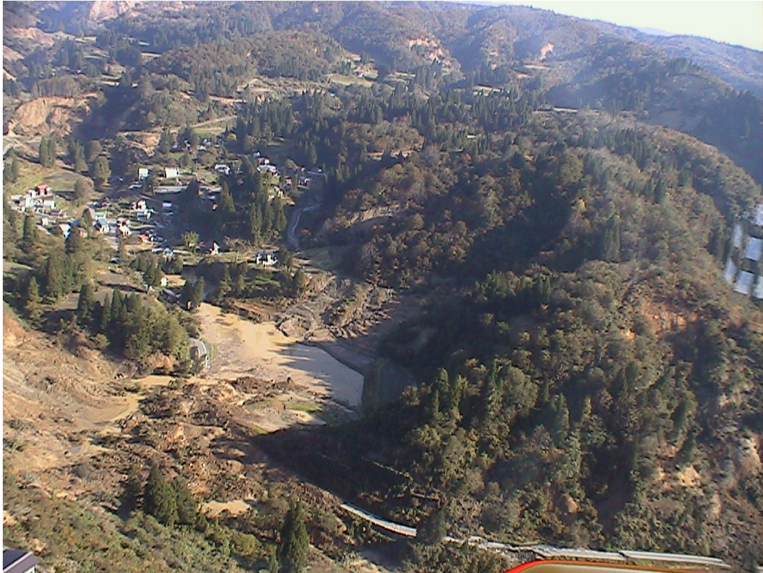
写真 G 5.6 南平で発生した河道閉塞（平成 16 年 11 月 28 日撮影）
