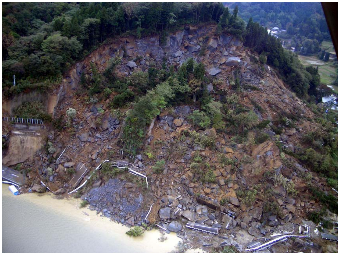
写真 G 5.9 妙見町で発生した斜面崩壊の全景（平成 16 年 10 月 27 日撮影）
