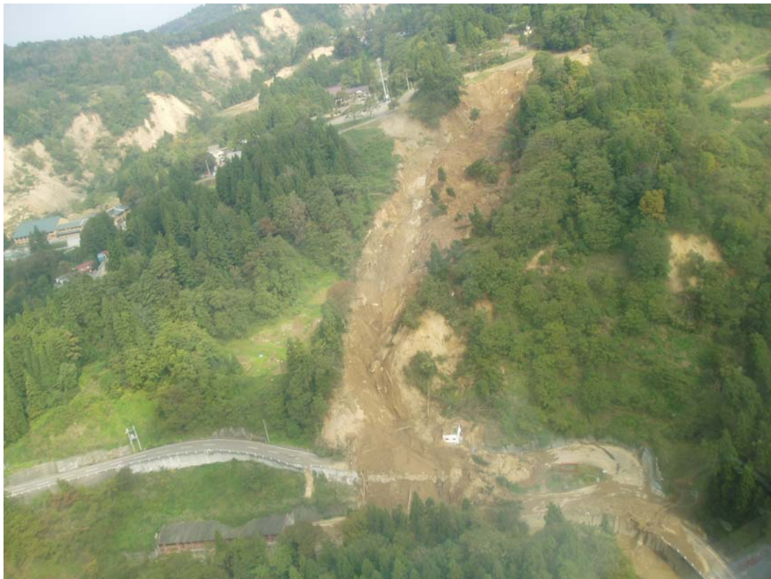
写真 G 5.3 斜面崩壊と山腹崩壊状況 小千谷市南荷頃、朝日川流域 （平成 16 年 10 月 25 日撮影）
