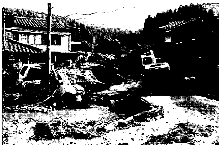
写真-2.5 土砂氾濫状況(美山町蔵作)
