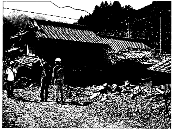
写真-4.3 三重県宮川村久豆地先土石流被災状況
