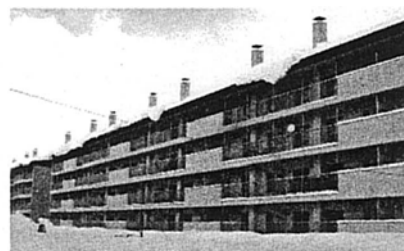
改修後の外観
