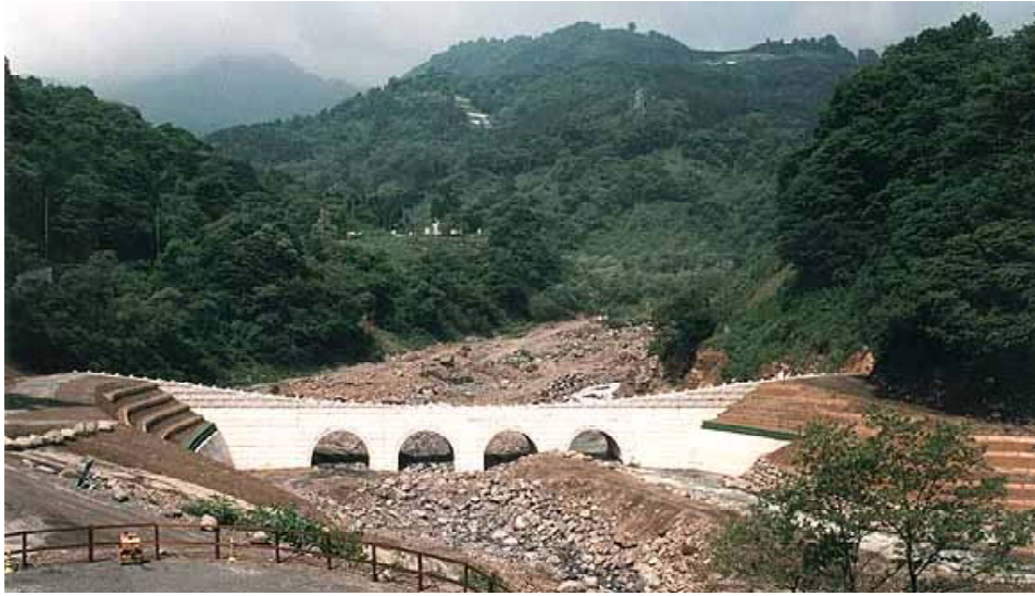
図－ 8.18 浦川スーパー暗渠砂防ダム（参考文献 2) より）
