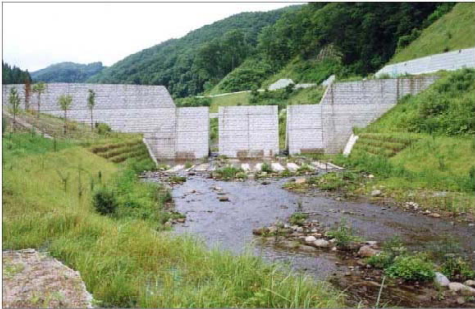
図－ 8.19 スリット型砂防ダム（淵沢川 十和田湖町淵沢地内）（参考文献 3) より）
