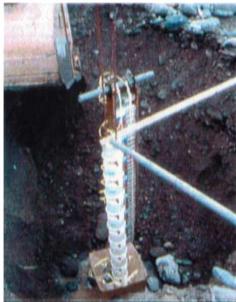
図－ 8.8 洗掘センサー (姫川)
